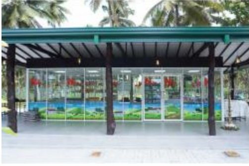
ඡායාරූප අංක 18 - මාරවිල ගොවිපොළේ නව අලෙවි සැලක් ඉදිකිරීම පුකෙப்பட. எண். 18 - மாவில பண்ணையில் புதிய விற்பனை நிலையமொன்றை நிர்மாணித்தல். Photo No. 18 - Construction of a new sales outlet at the Marawila farm
