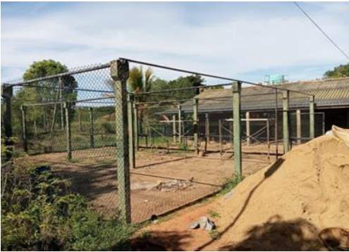
ඡායාරූප අංක 26 - තවත් ගොඩනැගිලි ප්‍රතිසංස්කරණය කිරීම ප්‍රකාශනය අංක 26 - ත්‍රිකුණාමලය කඳුකරය පුනරුත්ථාපනය Photo No 26 - Renovation of nursery buildings
