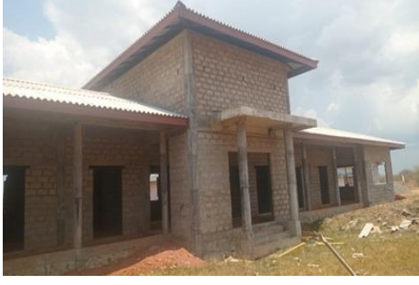
ඡායාරූප අංක 34 - මන්නාරම දිස්ත්‍රික්කයේ ඉලූප්පිකඩවායි ඌවිජන සේවා මධ්‍යස්ථානය ඉදිකිරීම புகைப்பட எண் 34 - மன்னார் மாவட்டத்தில் இலுப்பைக்கடவை விவசாய சேவை மையத்தின் கட்டுமானம் Photo no 34 - Construction of the Iluppaikadavai Agrarian Service Center in the Mannar District
