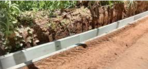
මොනරාගල දිස්ත්‍රික්කයේ බඩල්කුඹුර ප්‍රාදේශීය සභා බල ප්‍රදේශයේ වෙලන්හින්න- කිරිගල්පොත්ත මාර්ගයේ U වර්ගයේ පැති කාණු ඉදිකිරීම.
