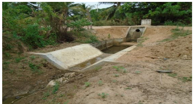
අම්පාර දිස්ත්‍රික්කයේ ගෝනගොල්ල ඒකකයේ G 23.1 ඇලෙහි ජල බැසුම් නිර්මිතය පිළිසකර කිරීම
