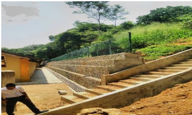
ගල්කන්ද කණිෂ්ඨ විද්‍යාලයේ පාසල් ගොඩනැගිල්ලට යාබදව තිබූ අවදානම් බැවුම සඳහා පැති බැම්මක් ඉදිකිරීම
