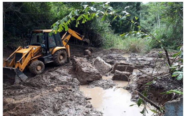
අමුණේ ඵලිපෙහෙලි කිරීම් සහ ඉදිකිරීම් කටයුතු සිදුකිරීම. මාගන්දන වාරිමාර්ග ව්‍යාපාරය (මොණරාගල)
