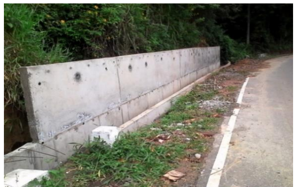
කොට්ටාගොඩ පොදුමිලිල යාලගමුව මාර්ගයේ කොන්ක්‍රීට් පැති බැම්ම , ගේබියන් බැම්ම සහ සෘජුකෝණාස්‍රාකාර කාණු කොන්ක්‍රීට්වලින් ඉදිකිරීම
