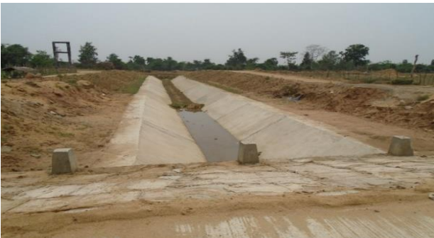
මඩකලපු දිස්ත්‍රික්කයේ රුගම් වාරි පද්ධතියේ පලාමඩු ඇළ මාර්ගය කොන්ක්‍රීට් අස්තරණ යොදා සකස් කිරීම
