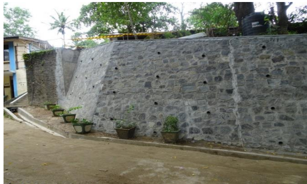
සිරිමල්වත්ත නවෝද්‍යා විද්‍යාලයේ අවදානම් තත්ත්වයේ තිබූ බැවුම සඳහා පැති බැම්මක් ඉදිකිරීම
