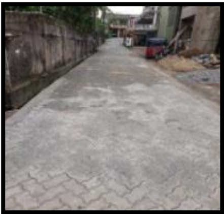
කොට්ඨාශය: කෝට්ටේ ව්‍යාපෘතිය: ස්ටැන්ලි තිලකරත්න මාවතේ ඇති පොදු ලීඳ අසල සිට පැලවත්ත පාර දක්වා ඇති අතුරු මාර්ගය ඉන්ටර්ලොක් ගල් අල්ලා සංවර්ධනය කිරීම
